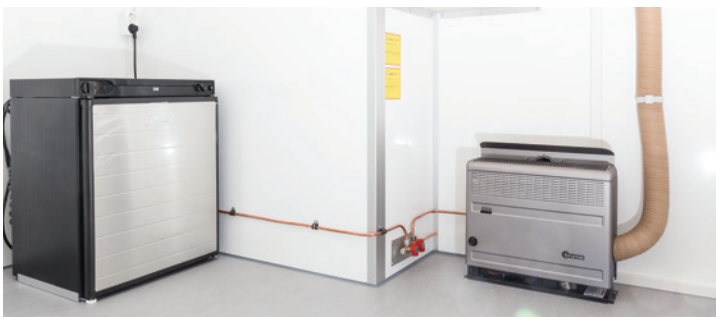
Kolmitoiminen jääkaappi toimii nestekaasulla tai 12/230-sähköverkoissa.
